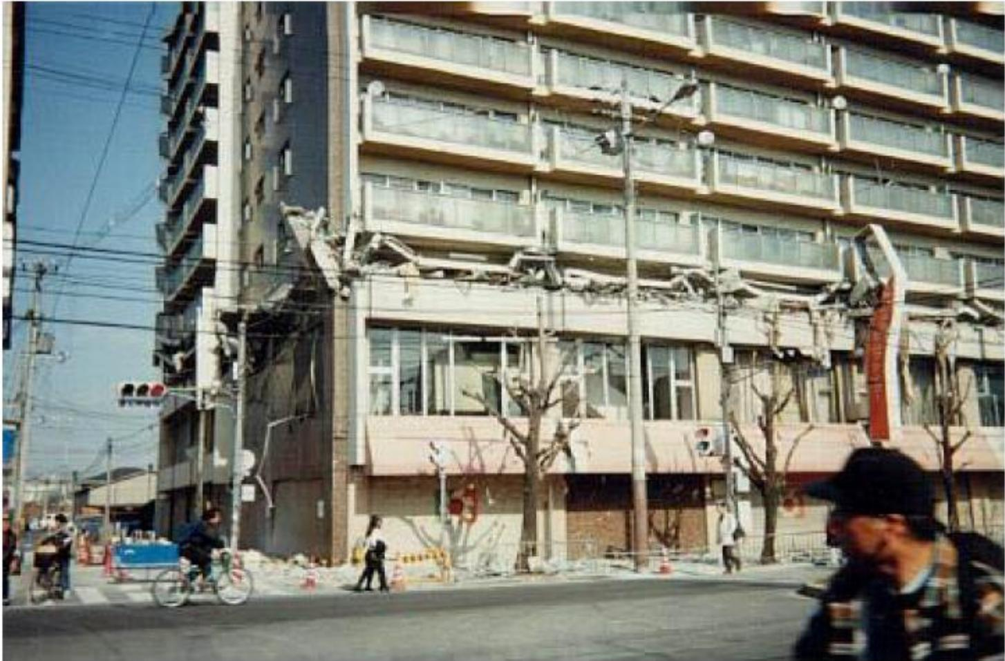
Kobe 1995  $M_w$  6.8 – Il collasso è avvenuto al terzo piano. Probabile irregolarità in alzato nella distribuzione delle masse o delle rigidezze.
